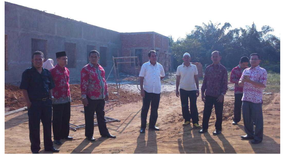
Kepala Kantor Wilayah Kementerian Agama Prov. Sumut, Dr. H. Tohar Bayoangin, M.Ag. didampingi Kasubbag Tata Usaha dan Kepala Seksi Pendidikan Madrasah Abd. Fatah ketika meninjau pembangunan Kantor Kementerian Agama Kabupaten Labuhan Batu Selatan yang dana pembangunannya murni bersumber dari APBD Kabupaten Labuhan Batu Selatan sekitar Rp. 1,8 Triliun.
